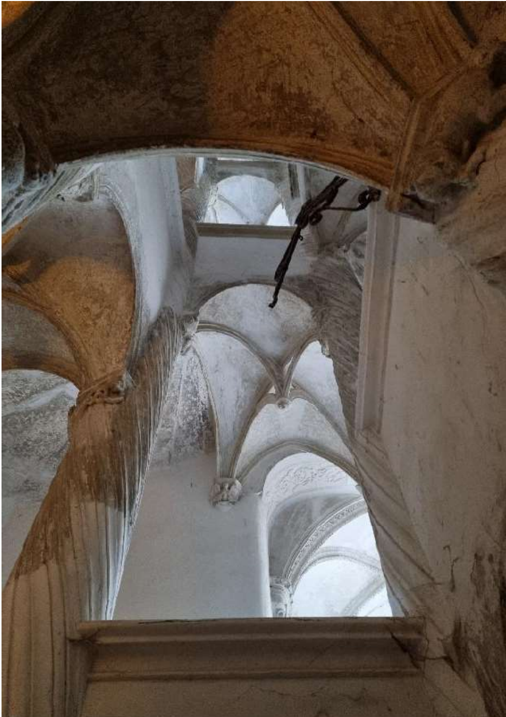
Figure 41 - Escalier de l'hôtel de Mazan à Riez
