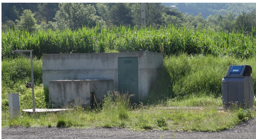
Station d'épuration sur lit de roseaux des Salles sur Verdon - auteur : Jean Carmille
