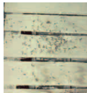
Déjections de chauves-souris sur ZTN (passerelle) (J. Fairon)
