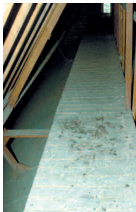
Traces de fouine, concentrées sur la passerelle dans les combles d'une église (J. Fairon)
