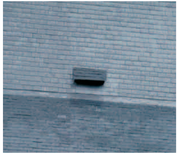
Chiroptière intégrée par les architectes de la Direction des Monuments, Sites et Fouilles dans le plan de restauration de l'église classée de Sensenruth, province de Luxembourg (J. Fairon)
