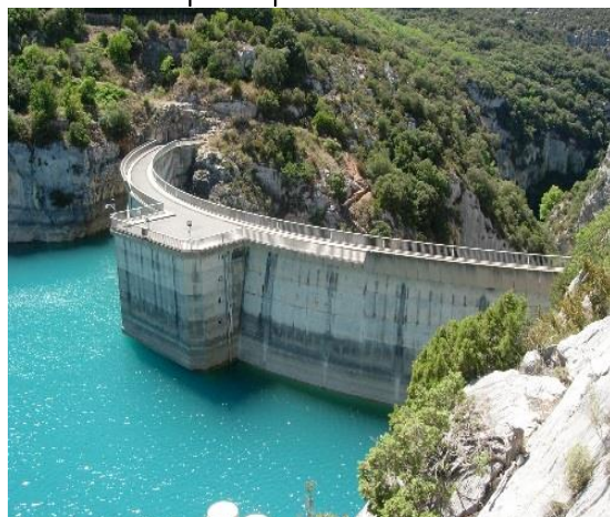
Barrage de Sainte-Croix © Parc naturel régional du Verdon
