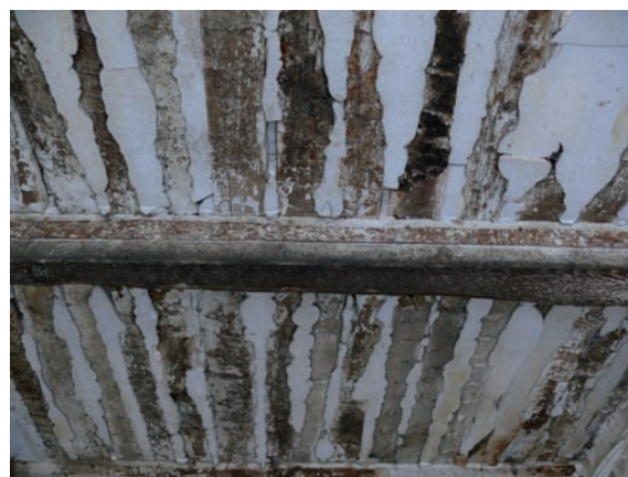
Sous-face de plancher à chevrons scellés dans un mortier de chaux ou de plâtre
