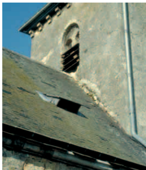
Prototype de chiroptière réalisé sur le toit de l'église de Metzert - Luxembourg (J. Fairon)
