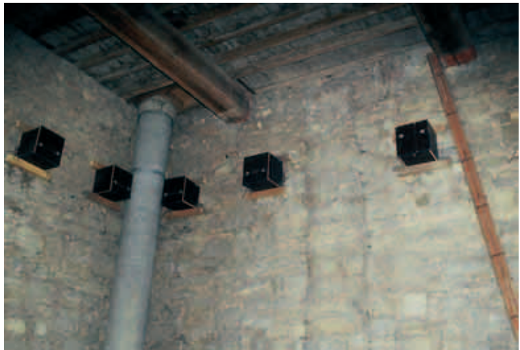
Batterie de nichoirs sur trous de boudin dans une tour d'église (J. Fairon)
