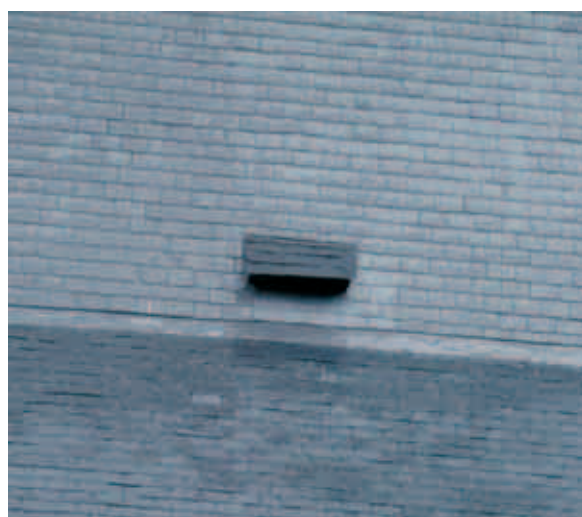
Chiroptière intégrée par les architectes de la Direction des Monuments, Sites et Fouilles dans le plan de restauration de l'église classée de Sensenruth, province de Luxembourg (J. Fairon)
