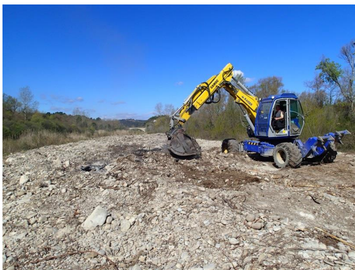
Photo Scarification à la pelle araignée à Gréoux-les-Bains - Guillaume RUIZ
