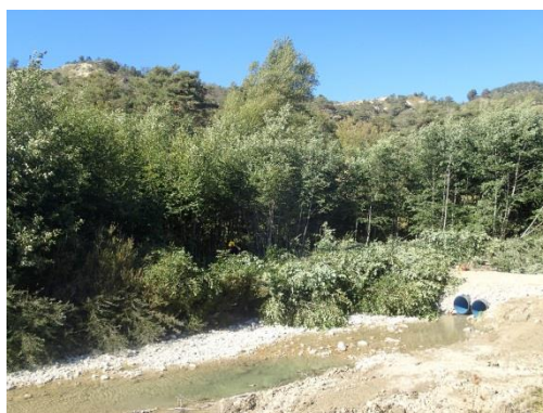
Photo de passage busé sur le Jabron à Brenon – Guillaume RUIZ
