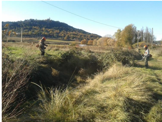
Photo de débroussaillage des ronciers en amont d'ouvrage à St-Julien le Montagnier – Guillaume RUIZ
