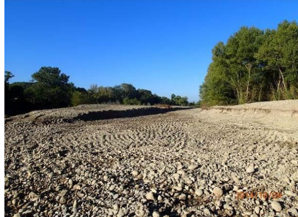
Photos Réalisation d'un chenal de crue pour limiter une érosion de digue à Vinon-sur-Verdon – Guillaume RUIZ
