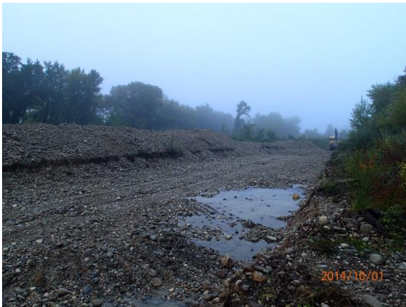
Photos Réalisation d'un chenal de crue pour limiter une érosion de digue à Vinon-sur-Verdon – Guillaume RUIZ
