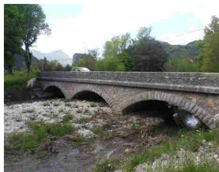
Stockage des matériaux en amont du pont
