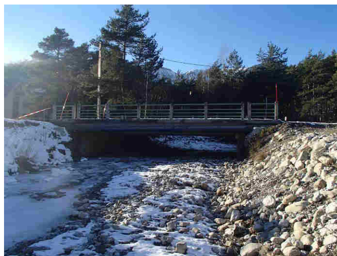
Exhaussement du lit sur la partie aval visible au pont de la D2
