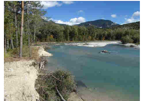
Erosion en RD en amont du pont de Carajuan - vue de l'aval
