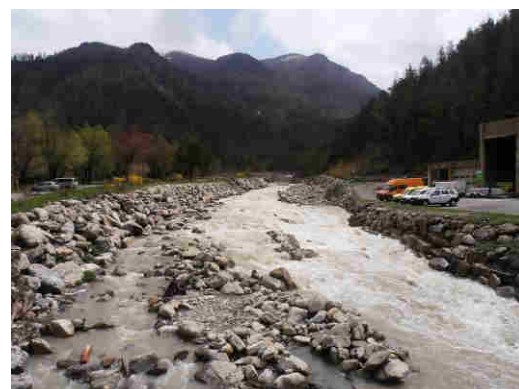
Endiguement sur la partie terminale Vue de l'aval
