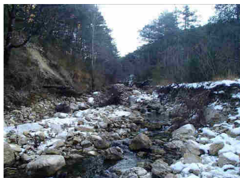
Lit du Riou, érosion de berges
