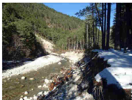
Erosion en RG (D2)
