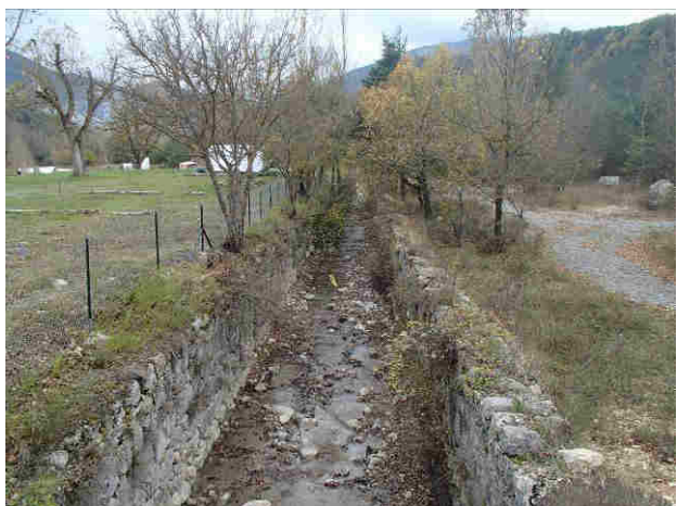
Canalisation du Rouret, partie aval
