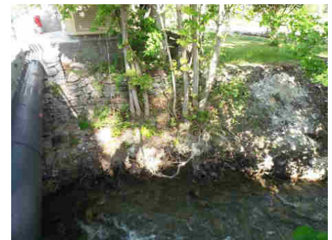
Affouillement en aval du pont de la D 702
