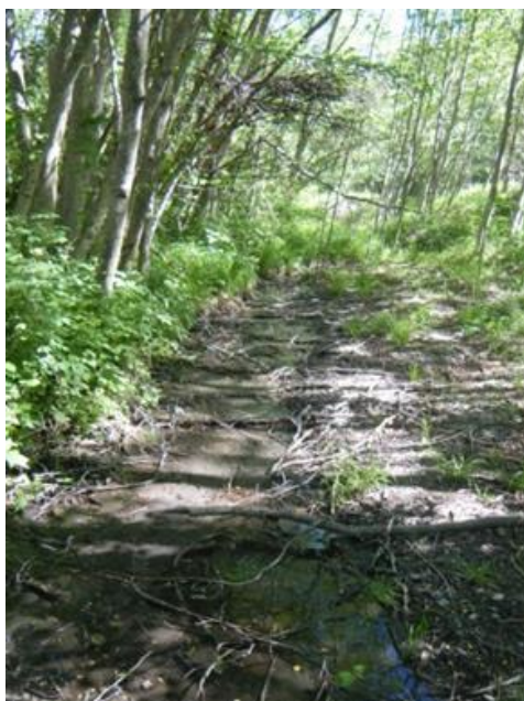
Adou de ribion (Allos) : linéaire encombré à réouvrir
