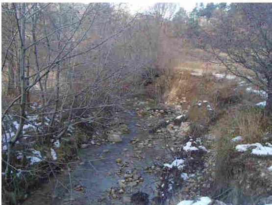
Zone d'érosion RG en amont d'un pont (route communale)
