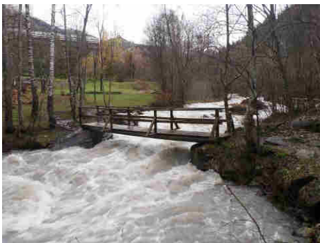
Passerelle du Pont, vue de l'aval - crue printemps 2013
