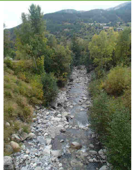
Le Bouchier en aval du pont de la D908 vue de l'amont
