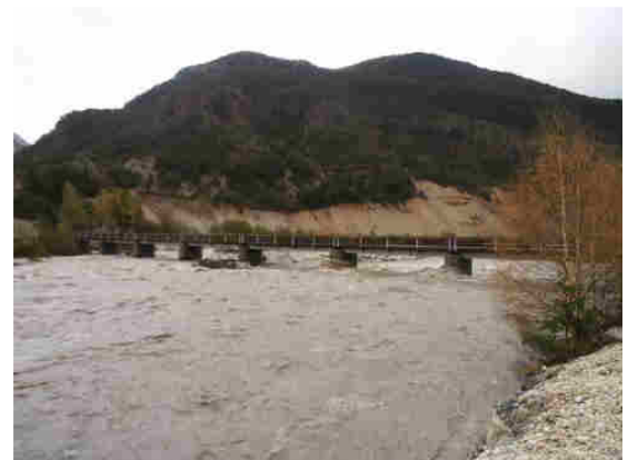
Amont du pont d'Ondres, crue de mai 2013
