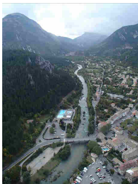
Traversée de Castellane - Verdon vu du Roc
