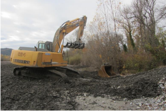
Pelle mécanique équipée d'un godet fleco (= râteau = multi-ripper)
