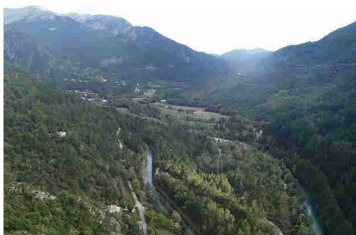
Canal de restitution de Chaudanne et tronçon court-circuité - vue du Roc
