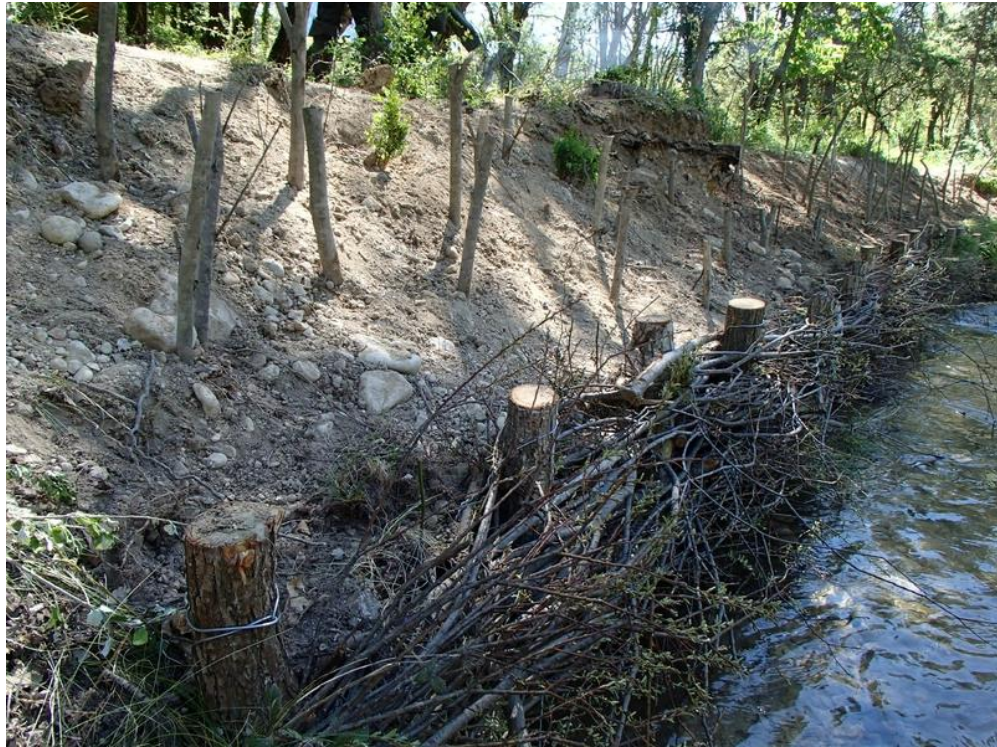
Tressage en pied de berge sur la Maïre à Moustier, vue de l'amont
