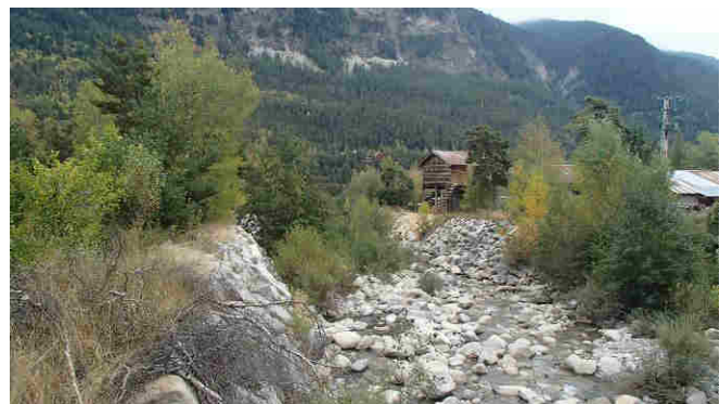
Végétalisation de l'espace intra-digues, aval du tronçon
