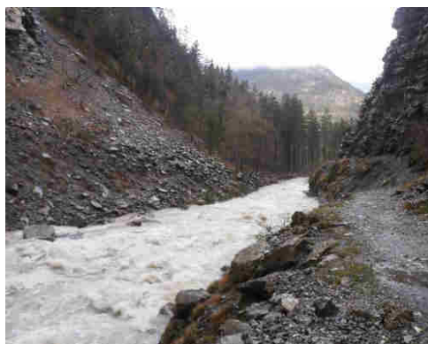
Versants abruptes et instables en aval de la cascade de la Lince
