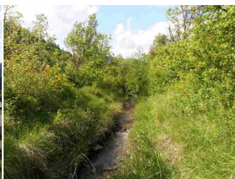
Végétalisation et réduction de la section d'écoulement du canal
