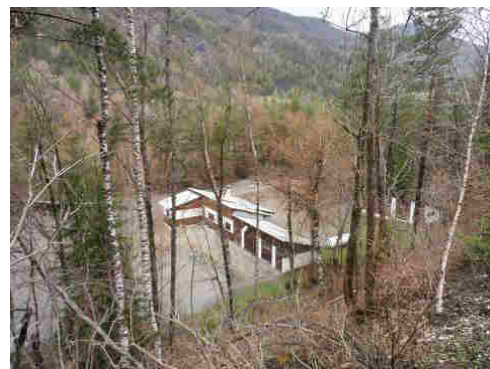
Amont du pont Haut, résidence secondaire inondée en mai 2013
