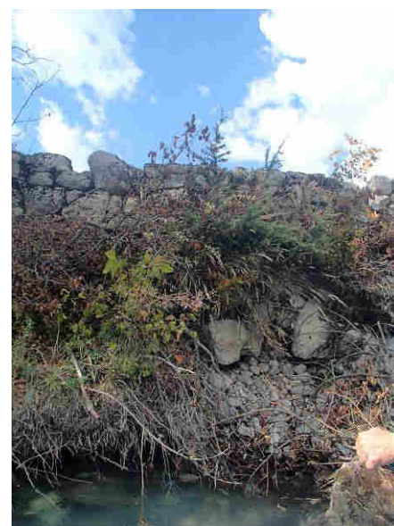
Erosion de la Barricade au droit de la STEP
