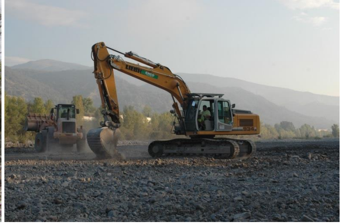
Pelle mécanique équipée d'un godet classique et chargeur en arrière-plan
