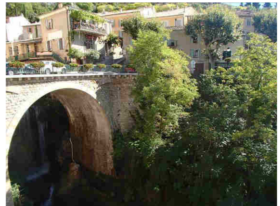
Ailantes en aval du pont de Notre Dame
