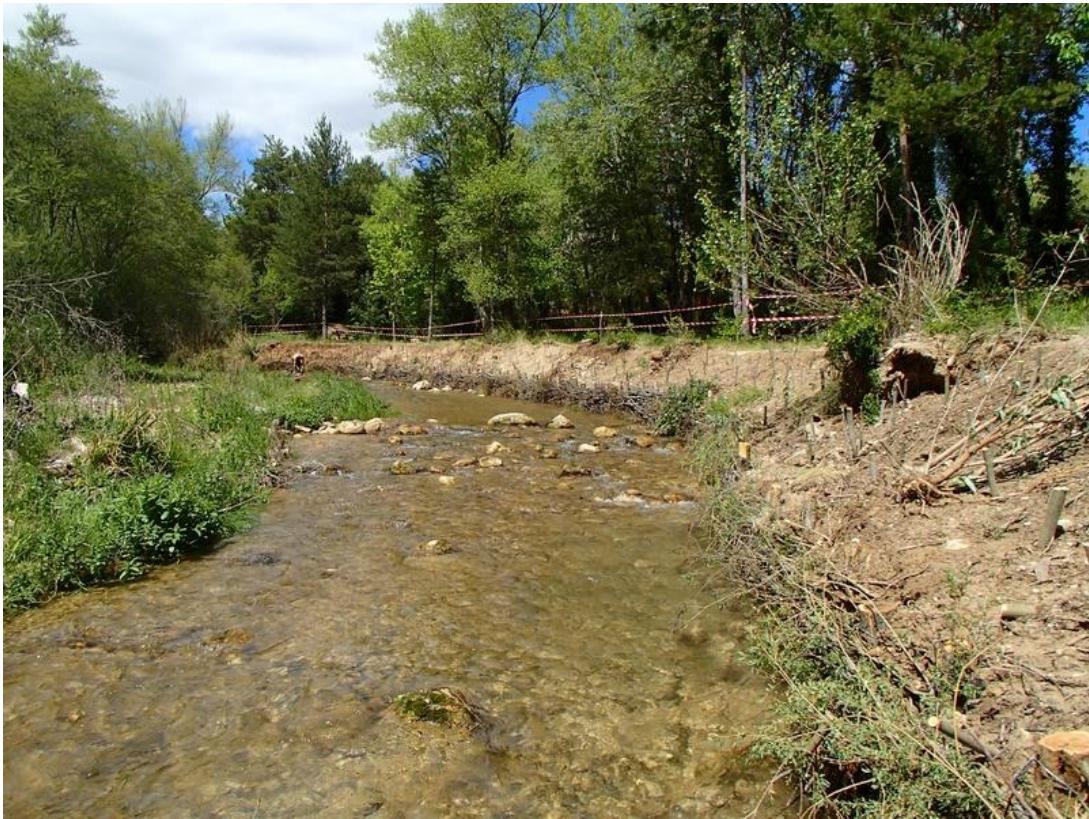
Vue de l'aval après travaux
