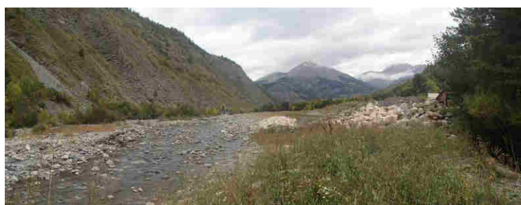
Elargissement du lit au niveau de la déchetterie - vue d'aval
