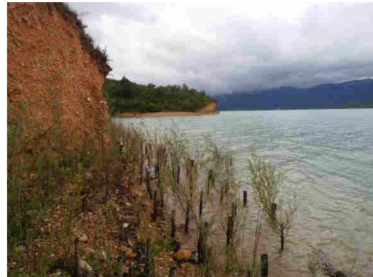
Chantier expérimental - bouturage de saules à Sainte Croix
