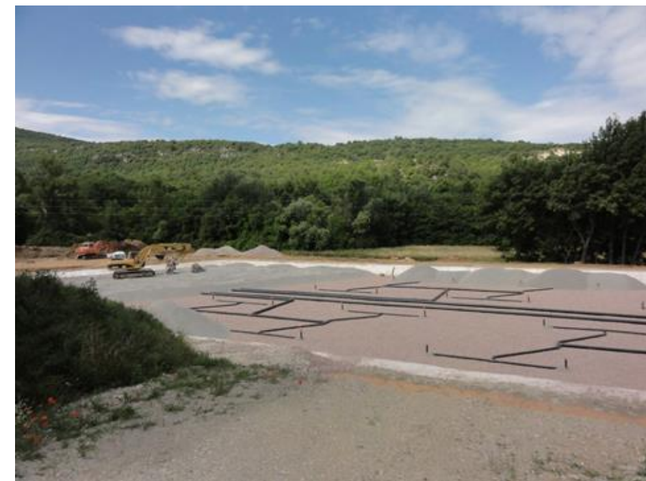
Construction de la station d'épuration de Bauduen (C. GUIN)
