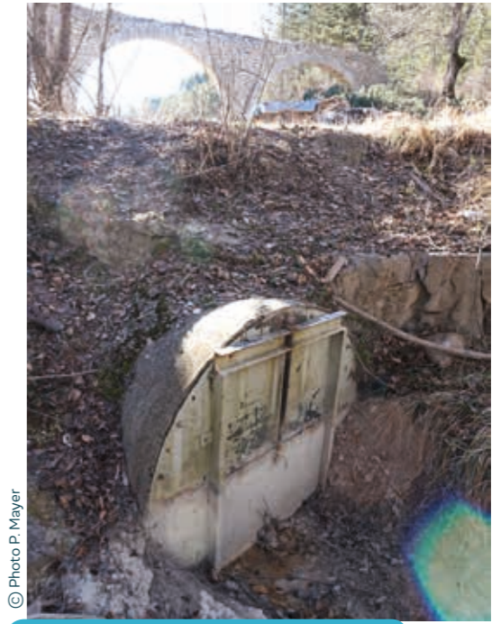
Nouvelle prise du canal des usines suite aux crues de 1994.
