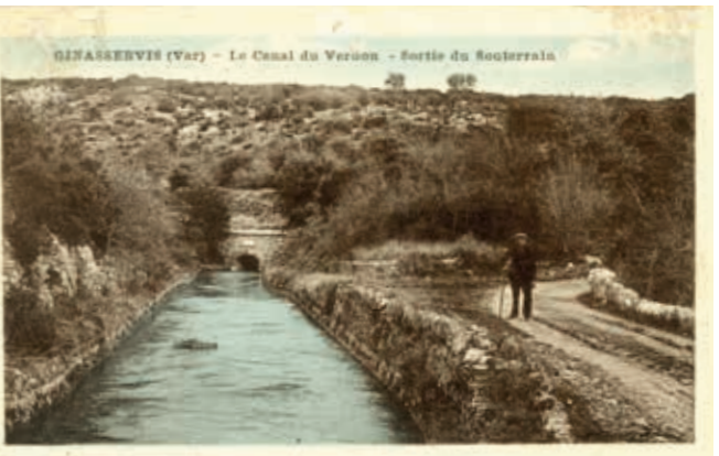
Sortie du souterrain à Ginasservis.
