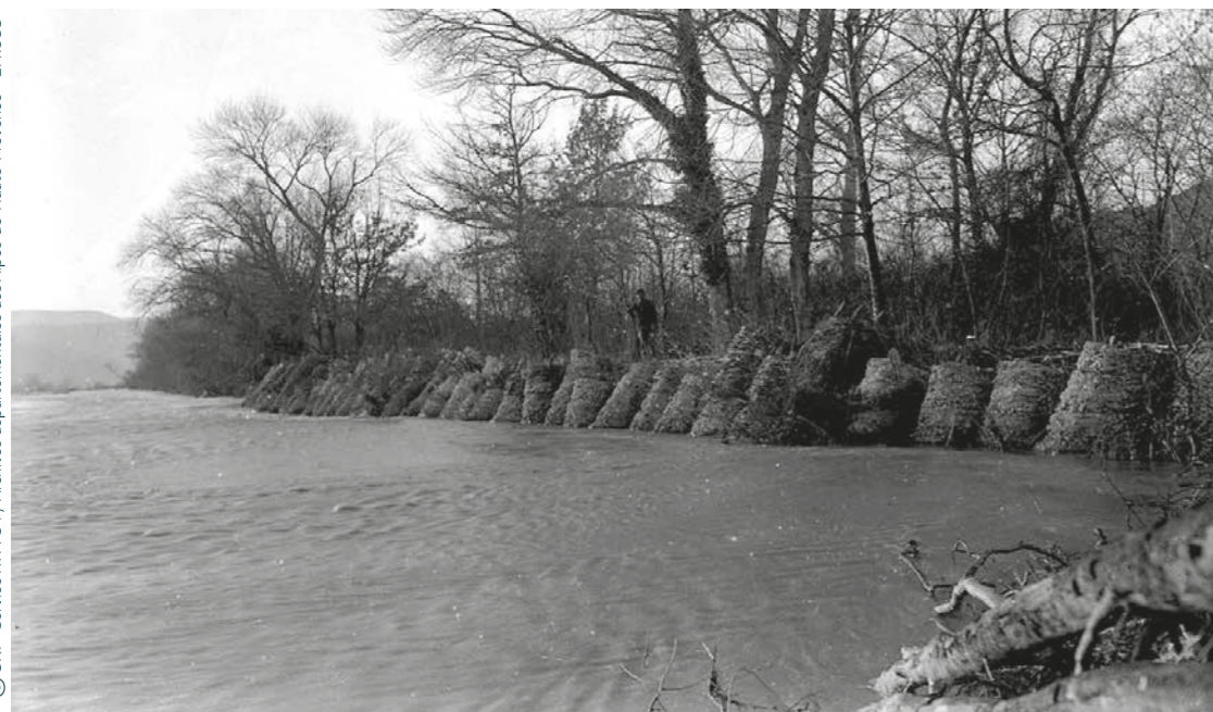
Gabions de protection, Mallemoisson.
