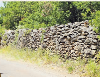
Muret de pierres sèches
