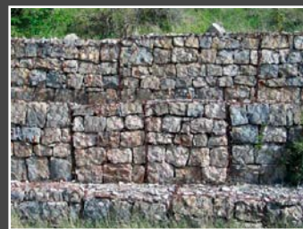
Gabions, Colle de l'olivier, Moustiers-Sainte-Marie
