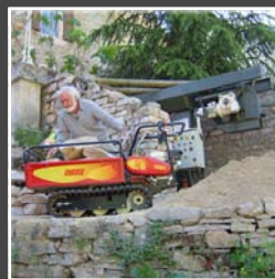
Chenillard, chantier de restauration à Haute Rive, Gorges du Tarn
