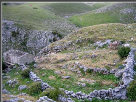
Restauration d'une cabane pastorale et de son enclos, Blieux
