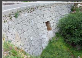
Mur de soutènement routier, Baudinard-sur-Verdon
