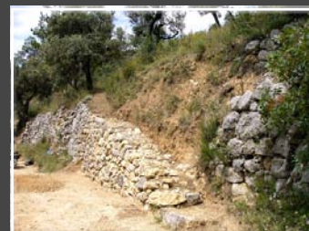
Aménagement d'une rampe d'accès dans une oliveraie, Moustiers-Sainte-Marie
